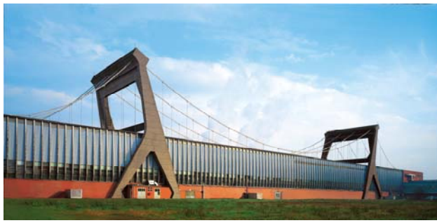
Lo stabilimento di Mantova progettato da Pier Luigi Nervi
