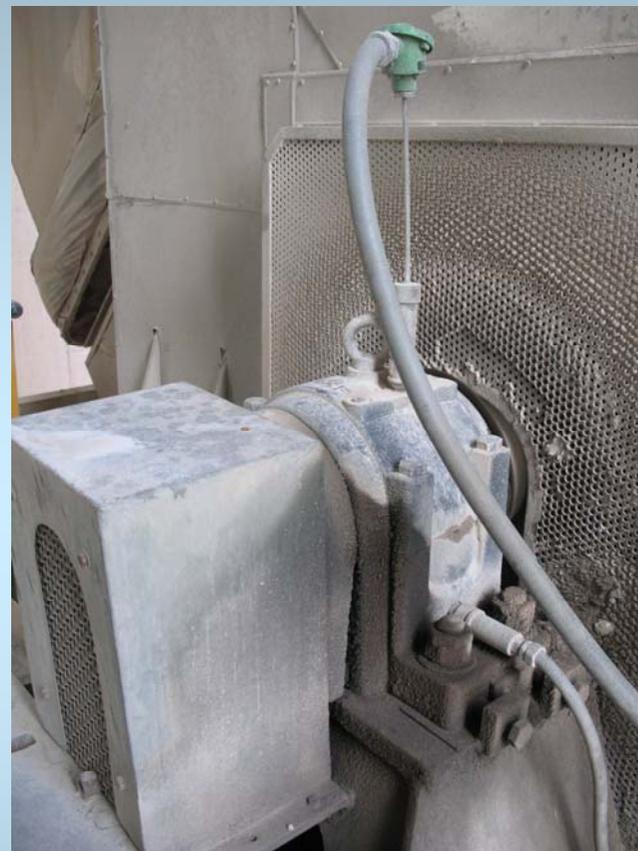
Il sistema di monitoraggio in continua permette di individuare le anomalie sul nascere e di seguirne l'evoluzione nel tempo
