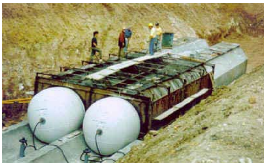
Esempi di tipologie di condotte monolitiche realizzabili con le casseforme pneumatiche tubolari SO.CA.P.
