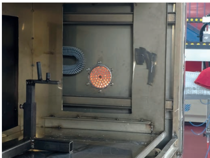
1 I tecnici Leister non solo hanno identificato le soluzioni più adatte, ma si sono occupati anche dell'accurato lavoro preparatorio
